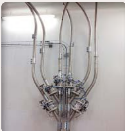
Multiplicidad de líneas para la alimentación del ciclofiltro con pesaje; permite la realización de la pre-mezcla durante la fase de transporte.
