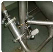
➤ Purgado de la línea
