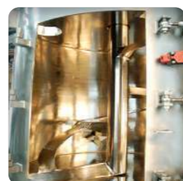
➤ Pulido de los elementos soldados para una terminación higiénica
